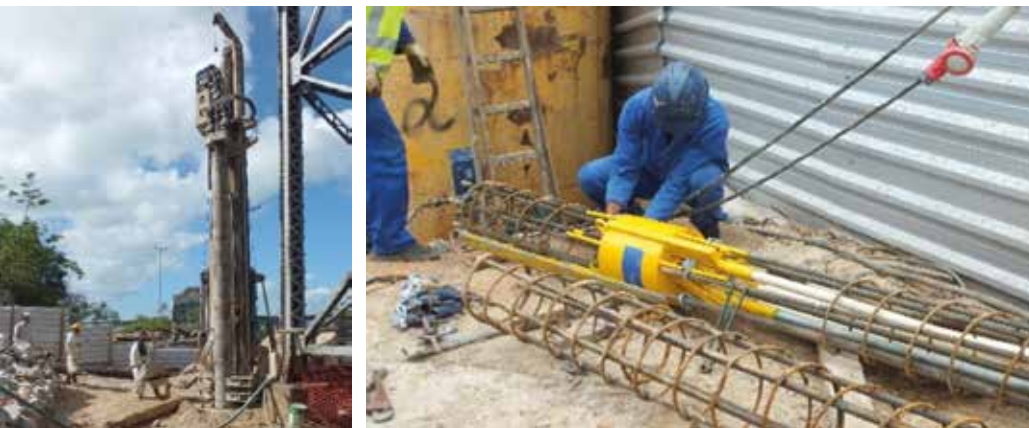
FIG. 4 – EXECUÇÃO DE ESTACAS RAIZ PELO EXTERIOR DA TORRE, MONTAGEM DE CÉLULA EXPANSIVA E FASEAMENTO CONSTRUTIVO DOS BLOCOS.
