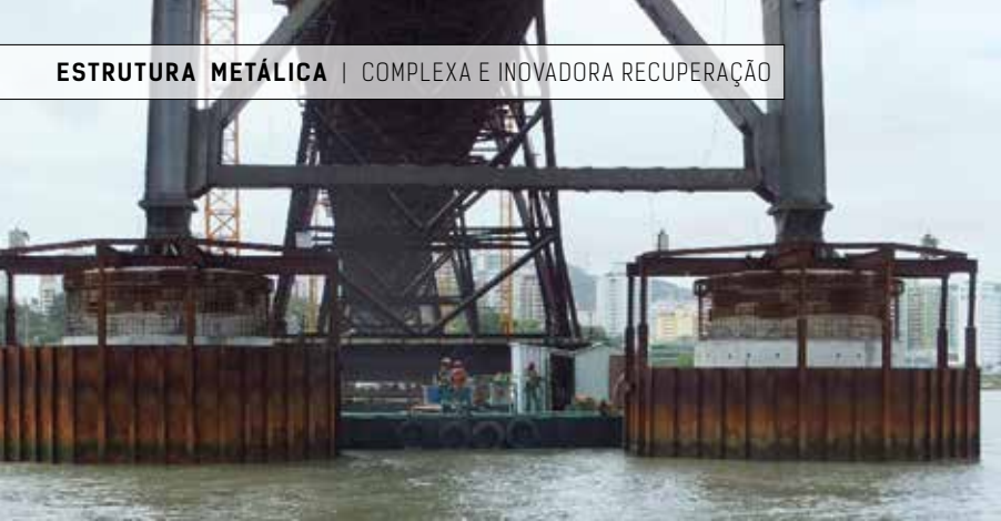
FIG. 5 – MONTAGEM E COLOCAÇÃO EM SERVIÇO DAS ENSECADREIRAS, PRIMEIRA FASE DE CONCRETAGEM E NÍVEL DE ESCORAMENTO.
