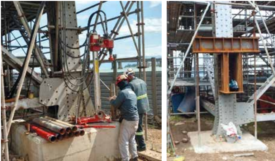
FIG. 3 – ENCAMISAMENTO, PERFURAÇÃO E TIRANTES TENSIONADOS.
