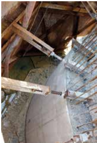
FIG. 5 – MONTAGEM E COLOCAÇÃO EM SERVIÇO DAS ENSECADREIRAS, PRIMEIRA FASE DE CONCRETAGEM E NÍVEL DE ESCORAMENTO.
