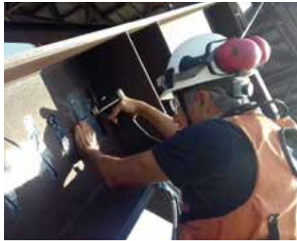
FIG. 8 – SENSORES ÓTICOS DE DEFORMAÇÃO (FS62) E DE TEMPERATURA (FS63). ACIMA À ESQUERDA: COMPÓSITOS. ACIMA À DIREITA: SOLDÁVEIS. À ESQUERDA: PROCESSO DE SOLDADURA.
