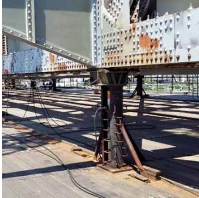
FIG. 7 – CILINDROS HIDRÁULICOS E CALÇOS POSICIONADOS SOB A TRELIÇA DO VÃO CENTRAL.
