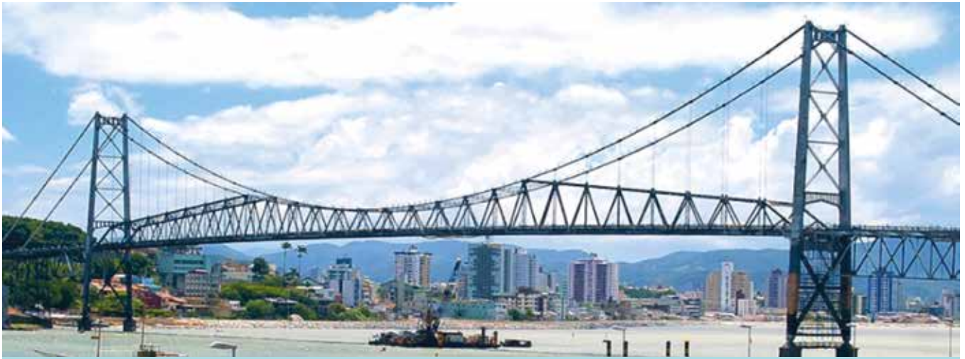
FIG. 1 – FOTOGRAFIA DA PONTE ANTES DO INÍCIO DA REABILITAÇÃO. – FONTE: WWW.VIVENDOFLORIPA.COM.BR
