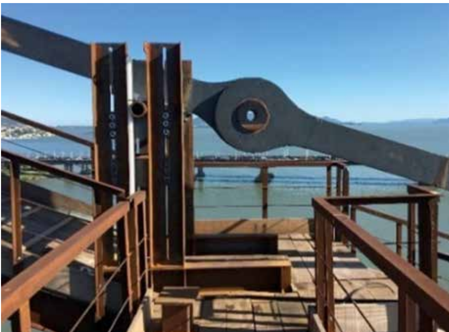
FIG. 6 – ESTRUTURA DE SUPORTE PROVISÓRIA PARA CILINDROS HIDRÁULICOS JUNTO AOS OLHAIS DAS BARRAS DE LIGAÇÃO AOS MACIÇOS EM TERRA.
