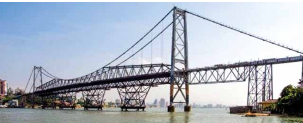
FIG. 2 – ESTRUTURA DE SUPORTE PROVISÓRIA.
