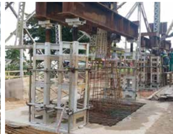
FIG. 4 – EXECUÇÃO DE ESTACAS RAIZ PELO EXTERIOR DA TORRE, MONTAGEM DE CÉLULA EXPANSIVA E FASEAMENTO CONSTRUTIVO DOS BLOCOS.
